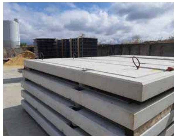
Installationsfertig: die vorgefertigten Betonsockel bei Lieferung
